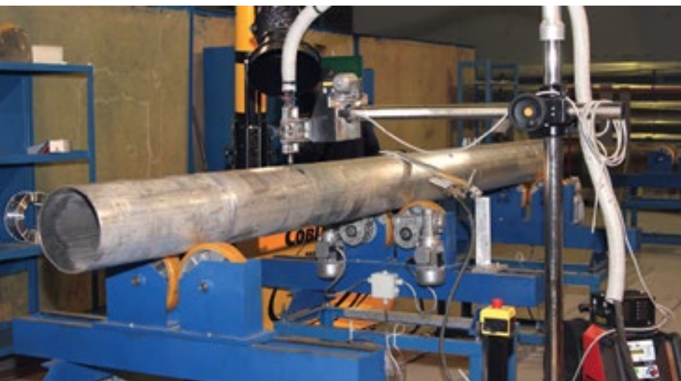
Сварка жесткой ошиновки
