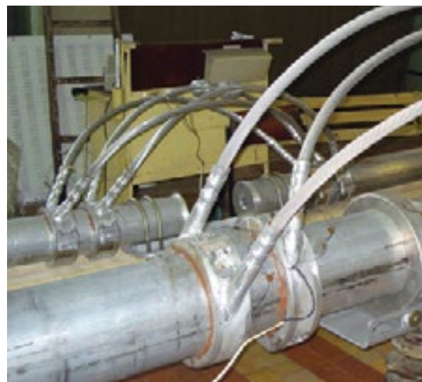
Испытания жесткой ошиновки
